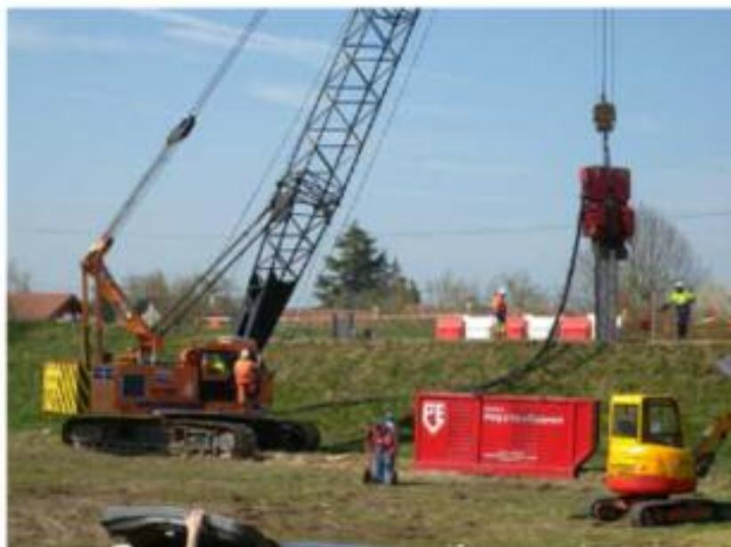
Figure 6: Renforcement par mise en œuvre de palplanches vibro-foncées à St Père-sur-Loire
